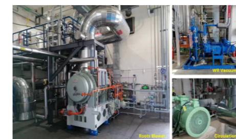
电气化 MVR 升级项目
